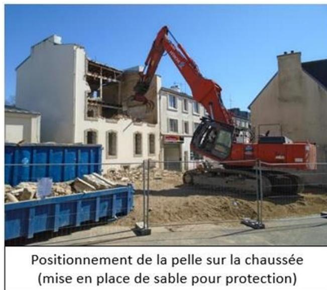
Figure 22 : Mesures de protection avant démolition (Source : APD – 3.6 – Installations de chantier, Le Du Hydro et Energies – octobre 2021)
