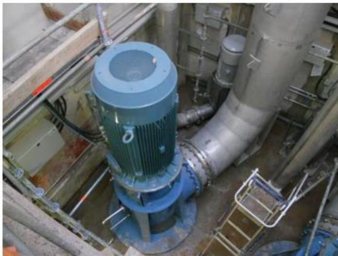
Figure 30 : Photo de la pose de la partie 3 de la pompe (Source : APD – 2.9 Méthodes d'exécution, Le Du Hydro et Energies – octobre 2021)
