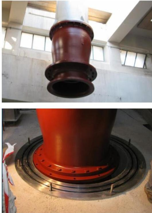
Figure 28 : Photo de la pose de la partie 1 de la pompe (Source : APD – 2.9 – Méthodes d'exécution, Le Du Hydro et Energies – octobre 2021)
