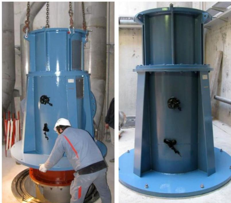
Figure 29 : Photo de la pose de la partie 2 de la pompe (Source : APD – 2.9 – Méthodes d'exécution, Le Du Hydro et Energies – octobre 2021)
